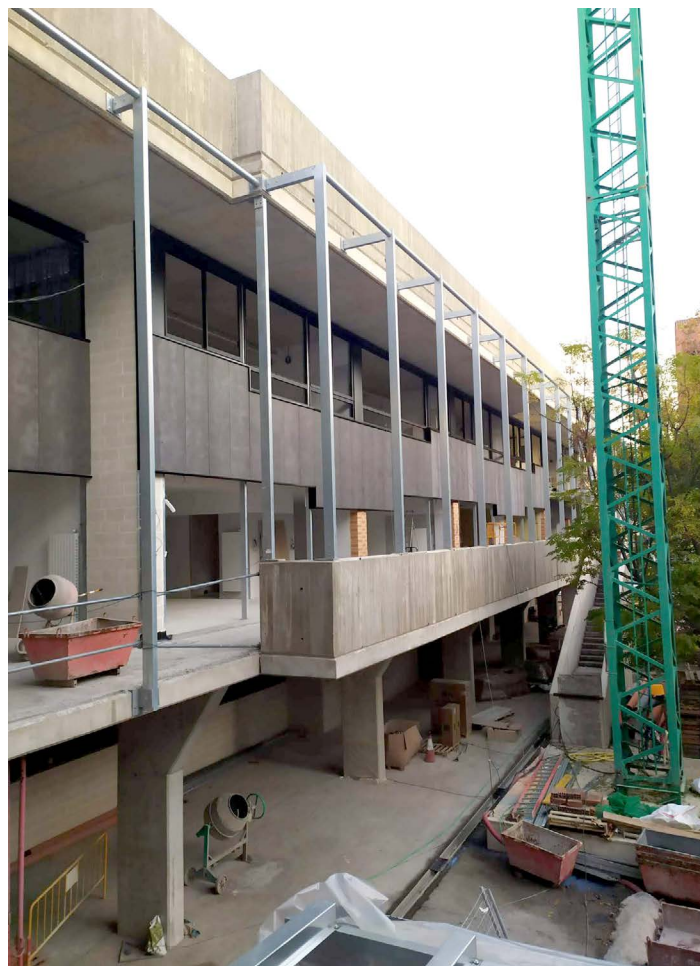
Estat de les obres el passat 23 de gener.
