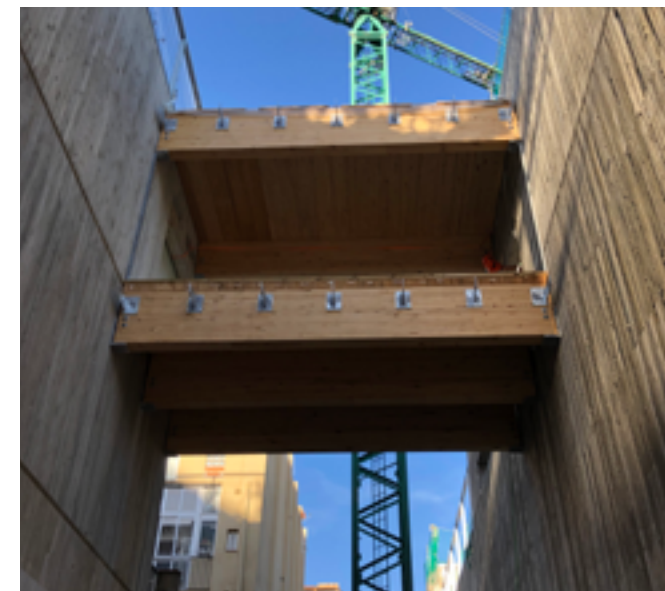
Obres passadís elevat entre edifici B i C.
