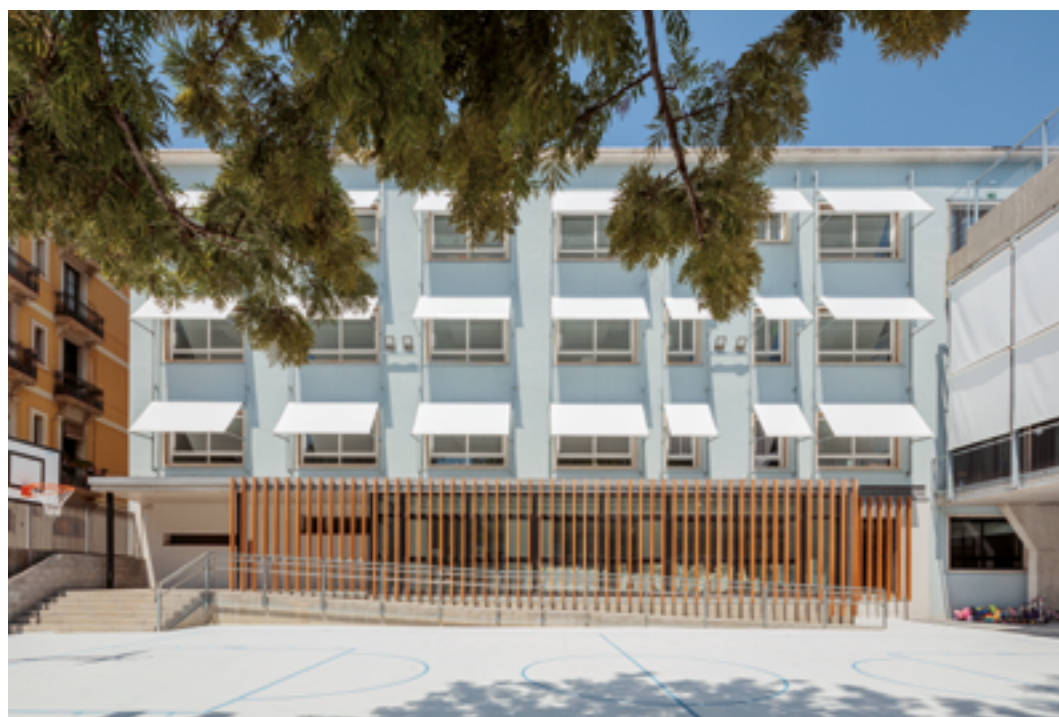
Façana edifici A.
