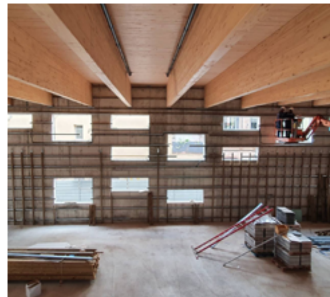
Obres a l'interior de l'edifici C.
